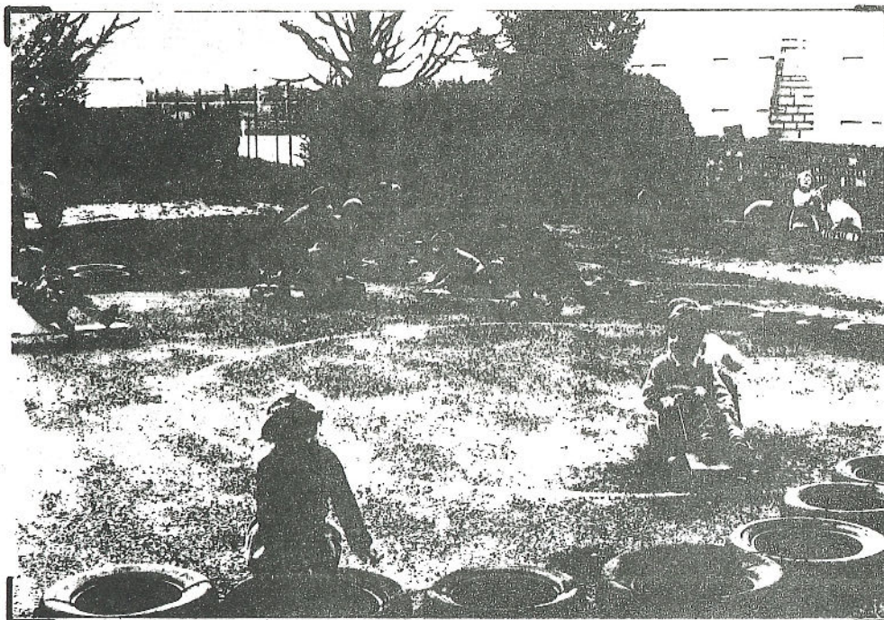
Le soir de la classe maternelle avant les travaux.
