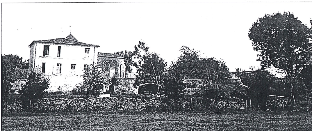
L'ancien presbytère vu de la grande prairie. Un vieux mur percé d'ouvertures en arcade soutient le jardin haut. De quand date-t-il ? Faisait-il partie d'un bâtiment très ancien aujourd'hui disparu ?
