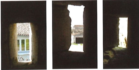
3 ouvertures dans les escaliers
