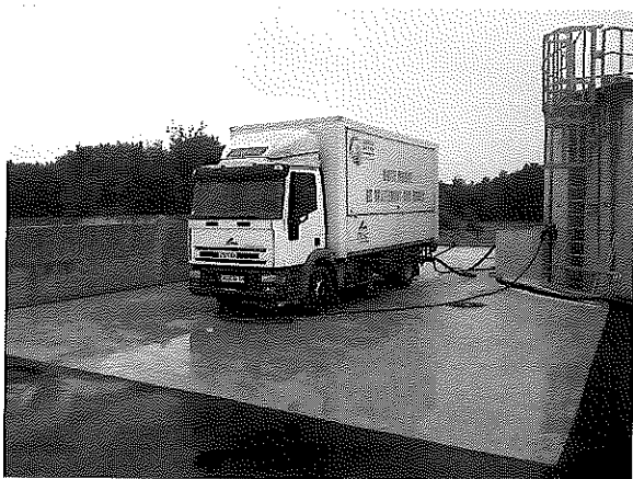
L 'unité mobile de traitement des boues à la station d'épuration de Bussac
