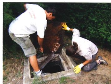
Ainsi, les techniciens procèdent à la vérification des installations chez les particuliers. Durant leur visite, ils vont contrôler : l'état et l'accessibilité des ouvrages, l'écoulement des effluents, l'entretien des ouvrages.
