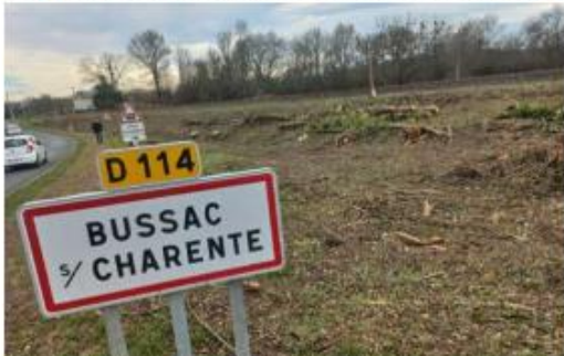
À Bussac-sur-Charente, l'entreprise mandatée par la SNCF a commencé les travaux de sécurisation des voies, fin janvier. B. AUGERET
