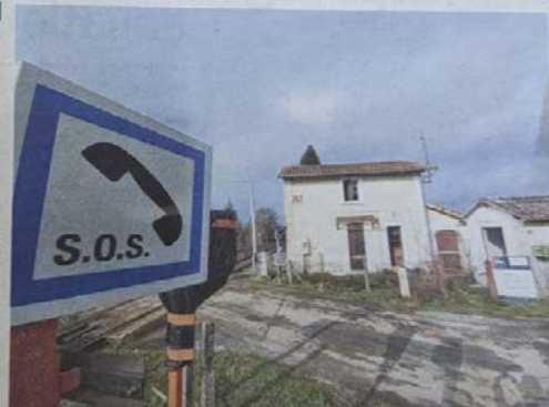
Le passage à niveau 242 se situe chemin du Vieux-Bourg, à Bussac-sur-Charente. La maison doit être démolie au cours du premier semestre 2023. E.L. SUD OUEST
